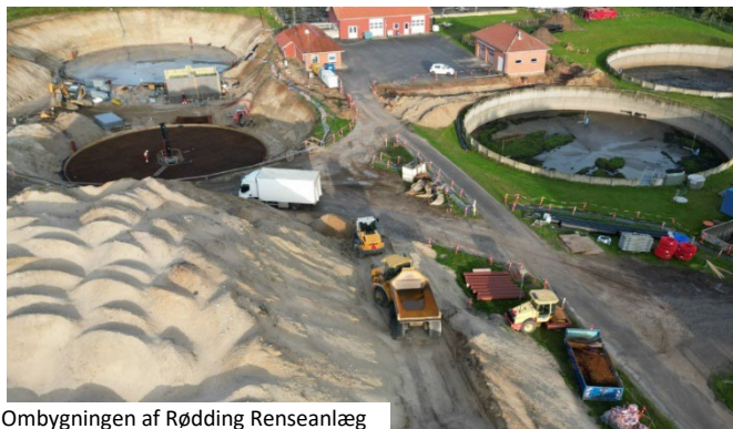
Ombygningen af Rødding Renseanlæg
