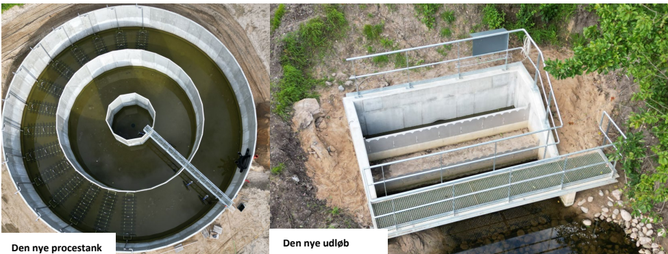
Den nye procestank
