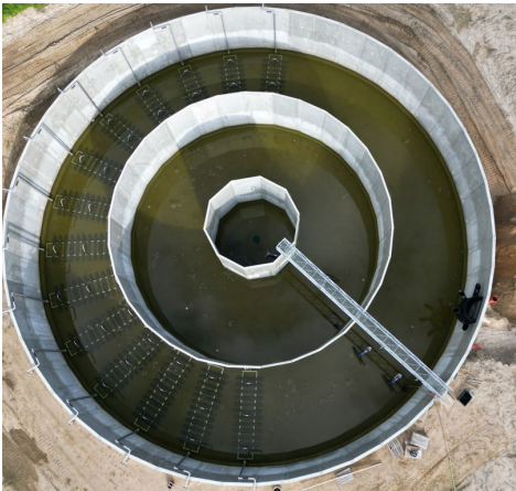
Den nye procestank
