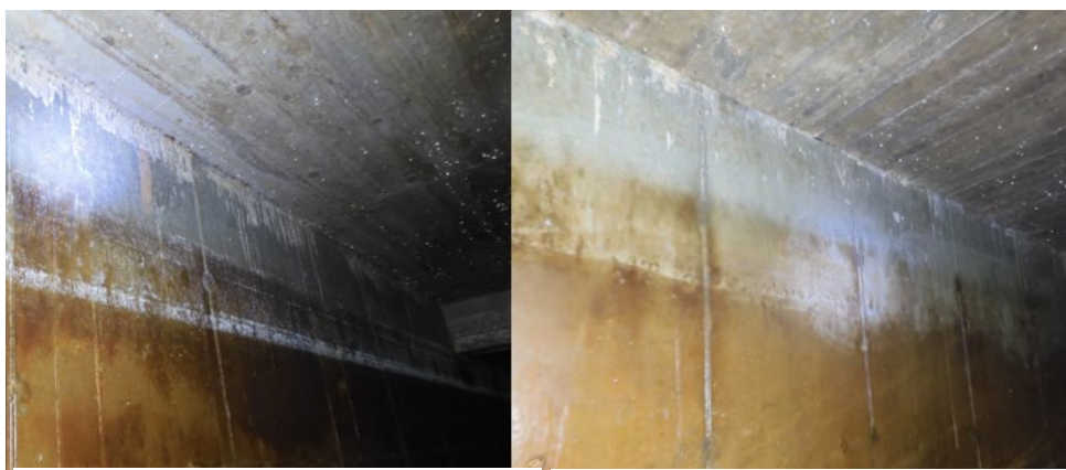
Vægge i tanken før rengøring
