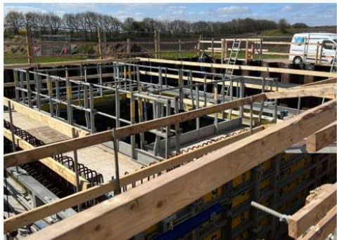
Igangværende byggeri på den nye pumpestation i Vejen syd
